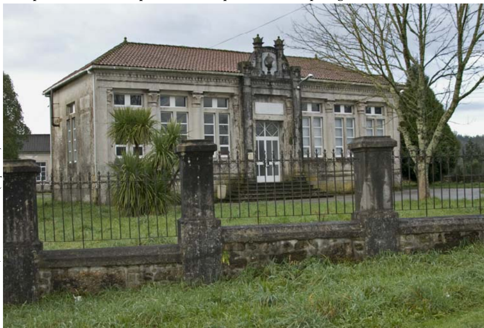
Vista da parcela desde a via de acceso
