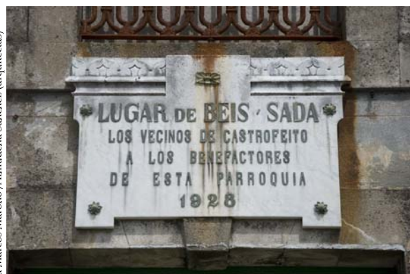
Placa na fachada principal
