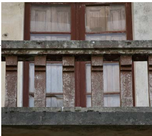
Detalle da balaustrada
