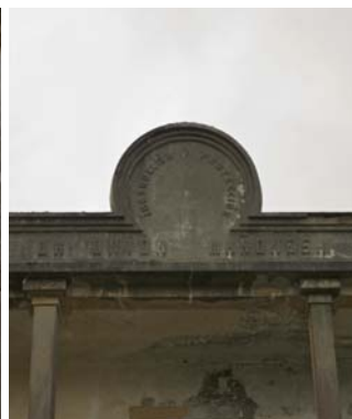
Detalle do remate da fachada
